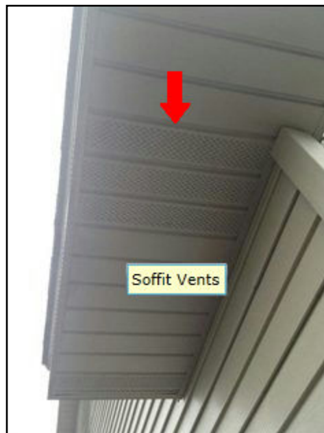
34. Soffit vent
